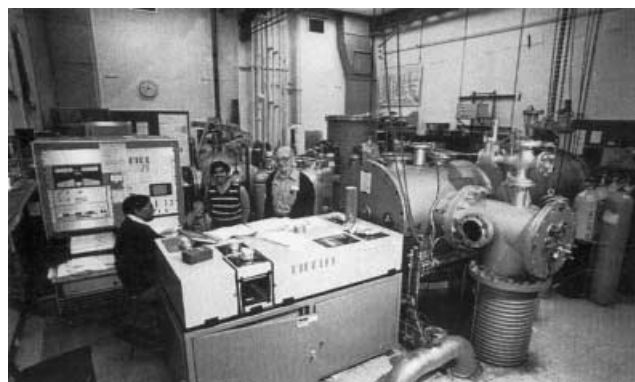
Abbildung 1. Unser „großes“ Molekularstrahlinstrument mit zwei 32“-Diffusionspumpen und einer 16“-Jet-Booster-Pumpe nach seinem Umzug von Princeton nach Yale. Mit im Bild sind S. P. Venkateshan (sitzend) und S. B. Ryali (Mitte stehend), zwei Postdocs aus Indien.
